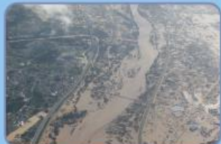
令和元年日本台風(台風19号) 写真提供:株式会社PSC
