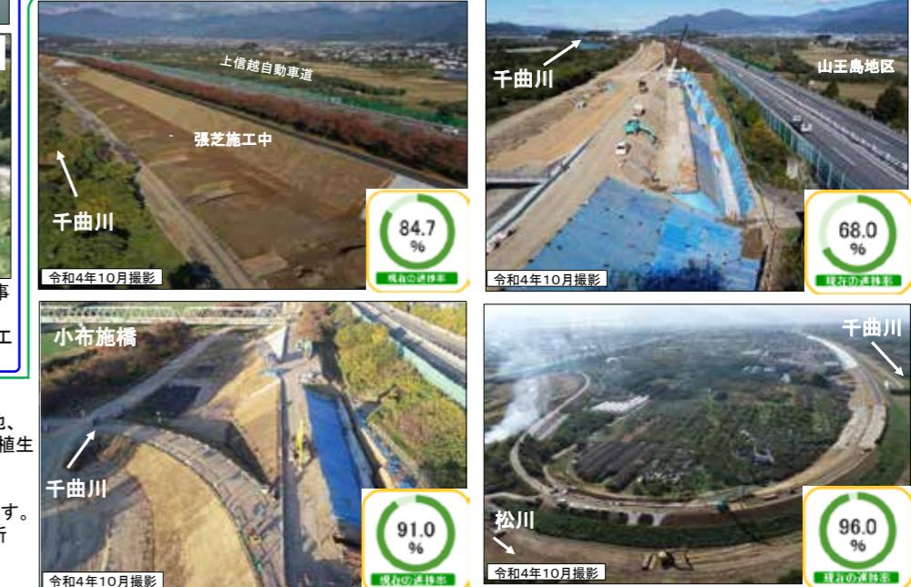
現在、護岸ブロックの施工を行っている他、ブロック施工が完了した箇所では覆土工、植生工、アスファルト舗装などを行っています。
