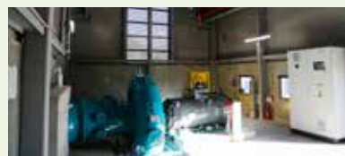
右_ 昨年稼働を始めた小水力発電所 下_ 建物内部のタービン
