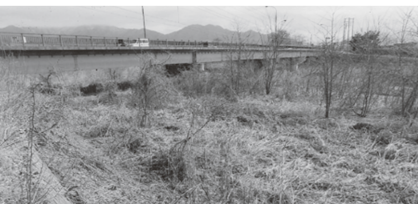
上松川橋付近の流域堤防
