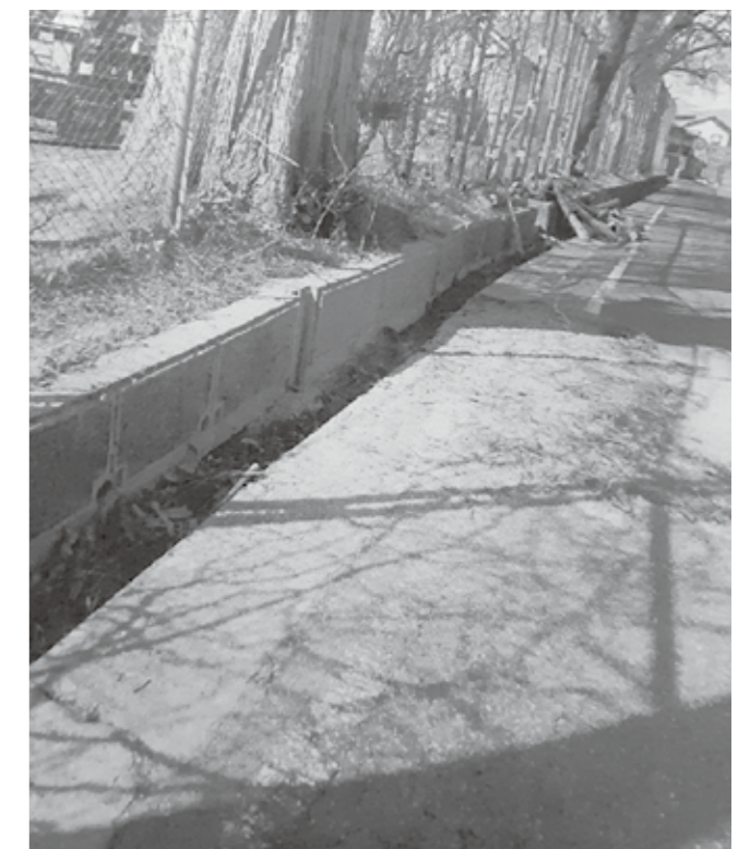
町営グラウンド北側道路改修
