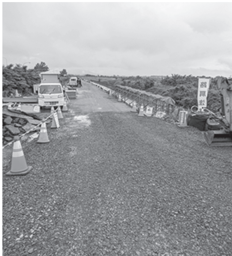
パーキングエリア西側 大島低水護岸堤防強化工事
