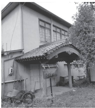
公表している町公共施設個別計画と老朽化した旧PTA会館
