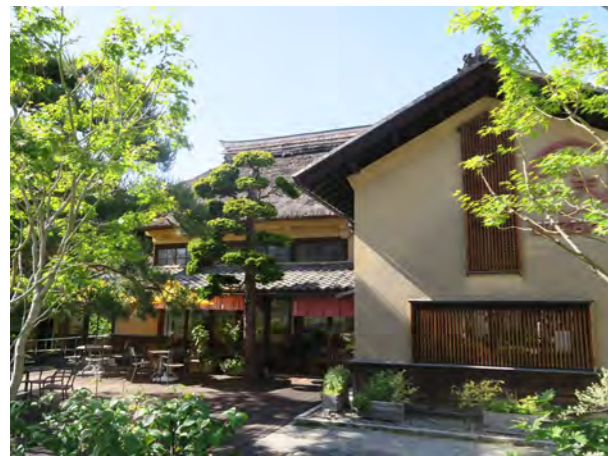
住宅をリノベーションした店舗。ゆったりとした中庭を持ち、緑豊かな外構を有している
