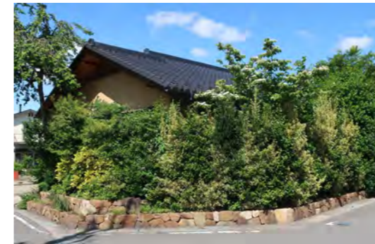
2段に分節された石積み擁壁+敷地側に植栽
