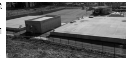
新しくなった町営配水池2,000tの貯留槽 ▶
