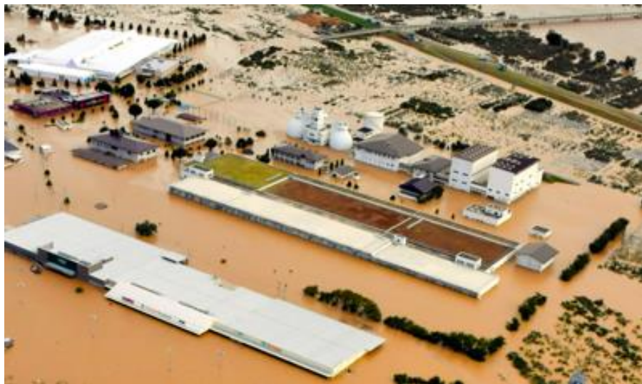
台風19号で浸水したクリーンピア千曲
