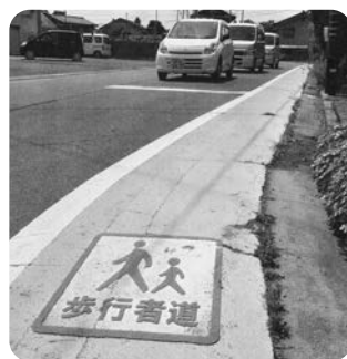
松村にあるカラー歩道
