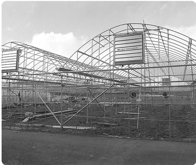
まもなく完成する建設中のハウス
