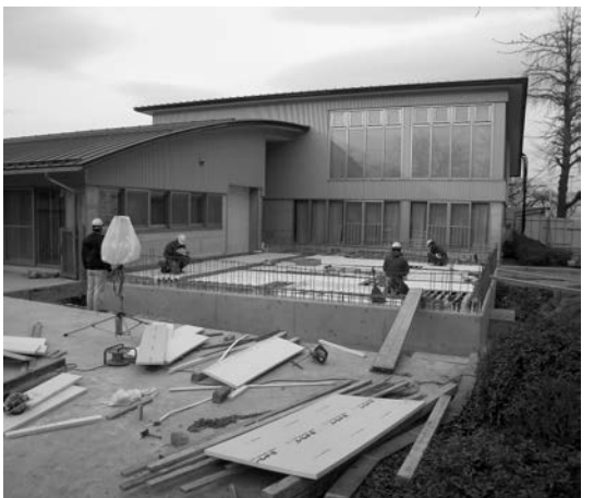
4月スタートを目指し急ピッチで増改築工事が進む栗ガ丘幼稚園
