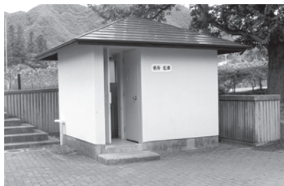
総合体育館前のトイレの現状
