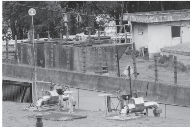
老朽化が目立つ配水池施設
