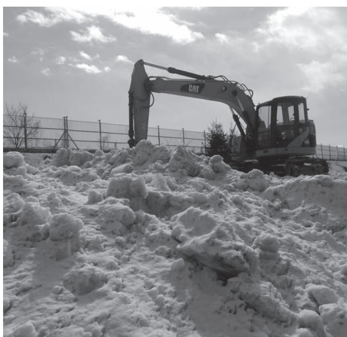
千曲川堤防上の大型重機による消雪作業
