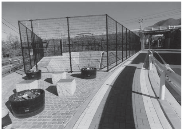
完成した伊勢町地区雨水調整池
