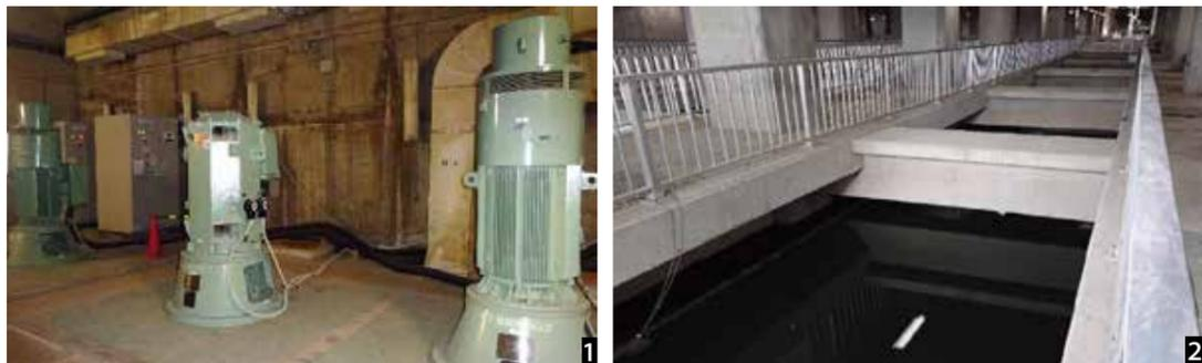
被災直後は仮設のポンプを設置していましたが、昨年10月に揚水ポンプが復旧し、現在は流入する下水を順調に汲み上げ、水処理施設へ送っています。水処理施設は令和元年12月から2系列、今年に入り残りの3系列が順次復旧しました。これで全ての系列が稼働し、被災前と同量の下水を浄化することができるようになりました。
