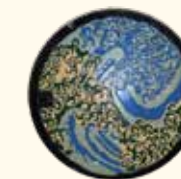
修繕に伴い設置替えを行っている鉄ぶた（公共下水、農業集落排水）
