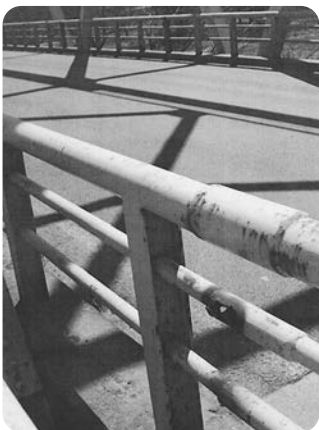
腐食して穴が開いた小布施橋欄干
