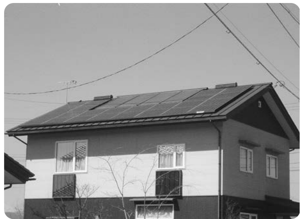
太陽光発電パネル設置住宅
