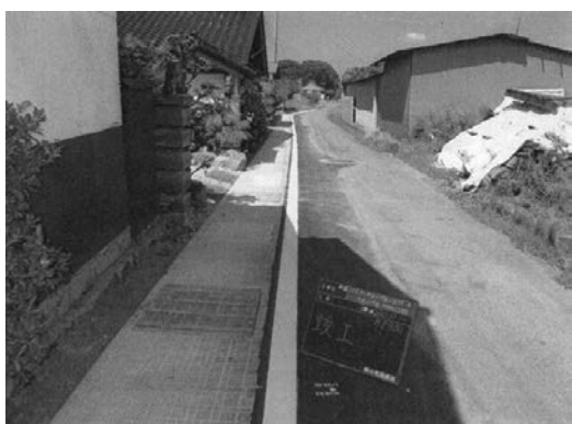
北部水路改良工事
