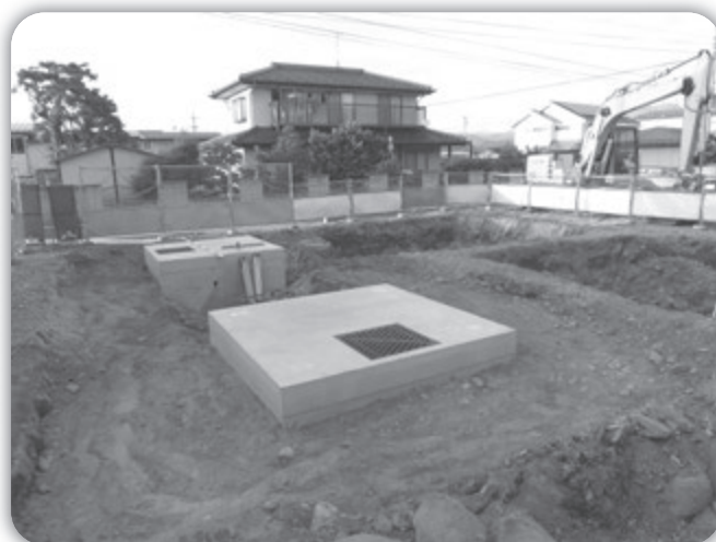
ゲリラ豪雨対策として浸透枳の設置を進めています（25年度繰り越し事業）
