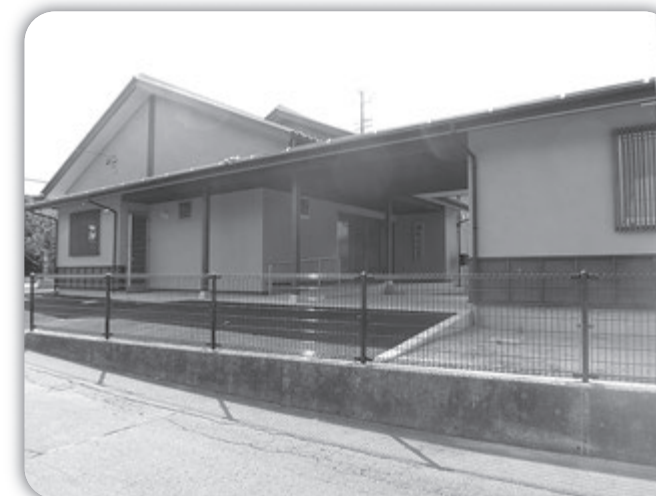
町内 11 自治会が町補助を受け、公会堂の耐震補強工事が進められています。（横町公会堂）
